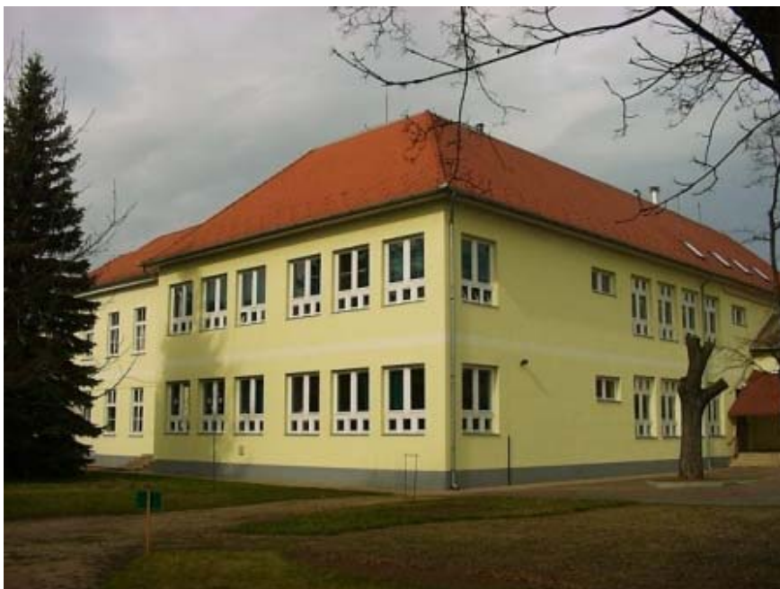
A megújult iskolaépület
