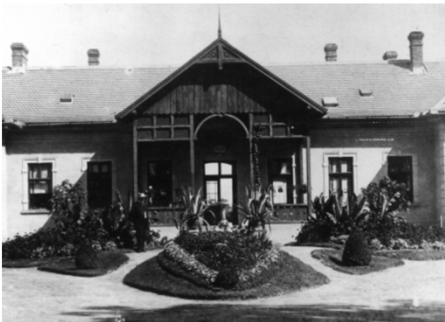
Az iskola főépülete
